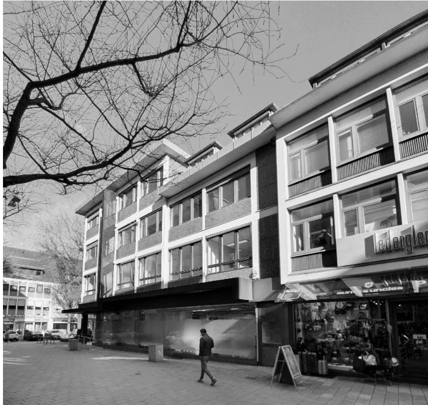
Ansicht Kieselmarkt Vorher
