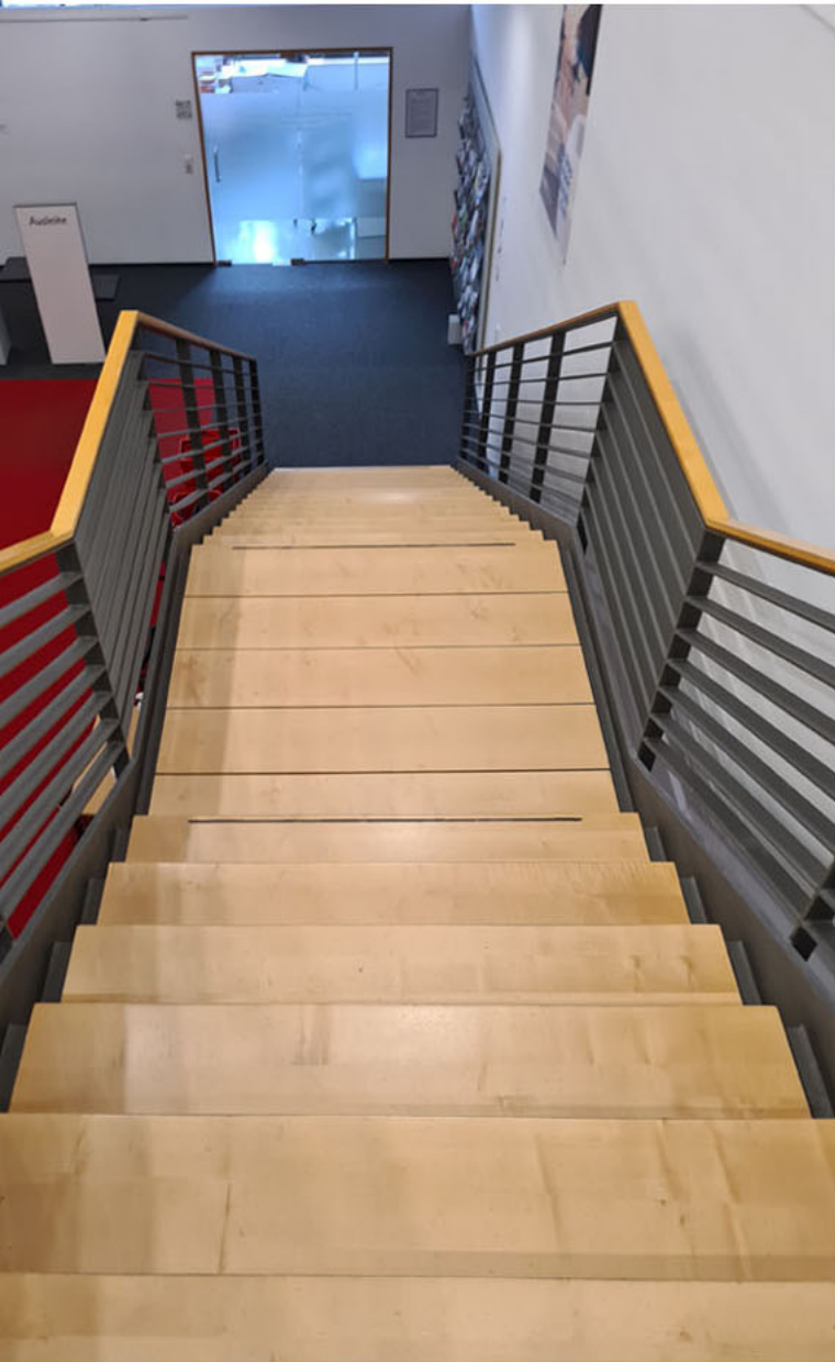
1.OG (vor Baubeginn)
