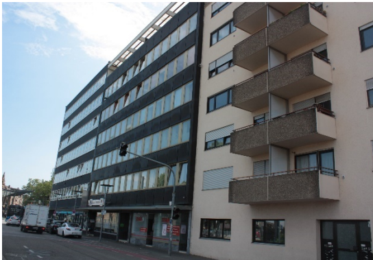
Abbildung 27: Gebäude mit Modernisierungsbedarf in der Bahnhofstraße
