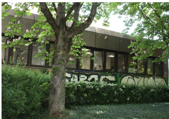
Abbildung 21: Rückwärtiger Gebäudeteil des Fleischer-Einkaufs Heilbronn-Hohenlohe eG
