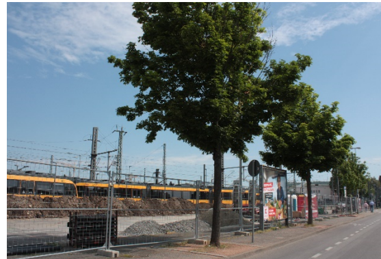
Abbildung 28: Bahnhofstraße mit parallel verlaufenden Gleisen des Zugverkehrs
