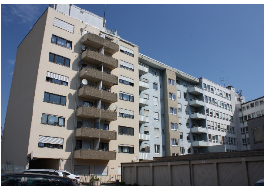
Abbildung 6: Rückseite der Wohngebäude Bahnhofstraße 37 und 39
