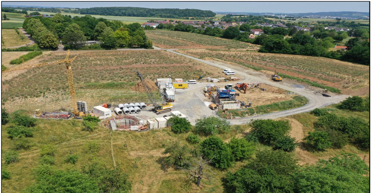
Abb. 1: Baustelleneinrichtung – äußere Erschließung Mühlberg/Finkenberg (Ansicht NO – Quelle HNVG)
