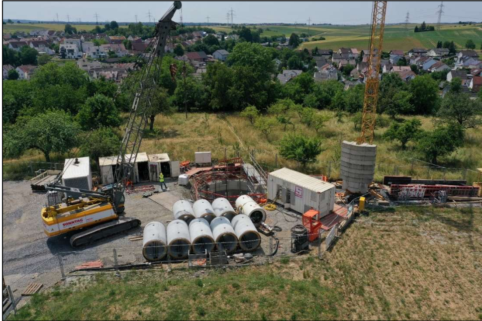
Abb. 2: RW-Entlastungskanal – Rohrvortrieb NW 1600 (Ansicht SW – Quelle HNVG)
