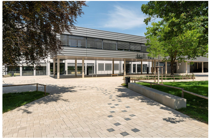
Schulhof nach Umbau
