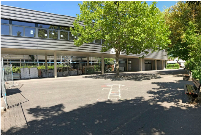
Schulhof vor Umbau
