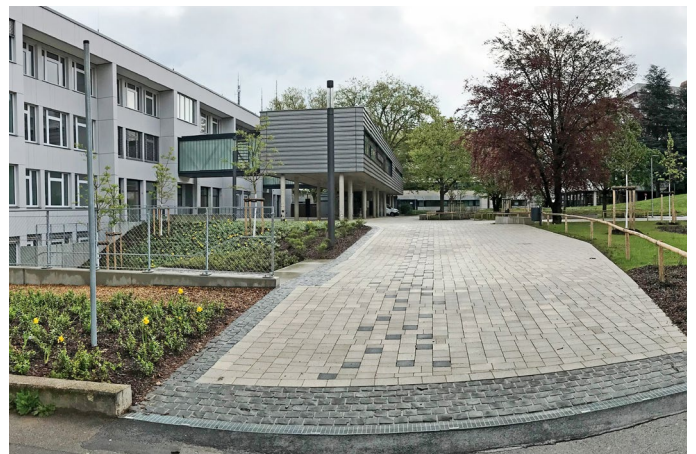
Zugang West nach Umbau
