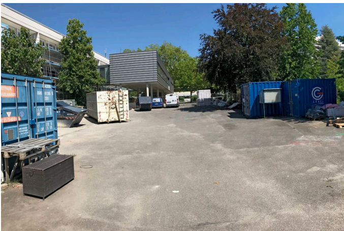
Zugang West vor Umbau
