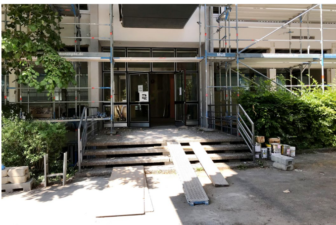
Eingang vor Umbau
