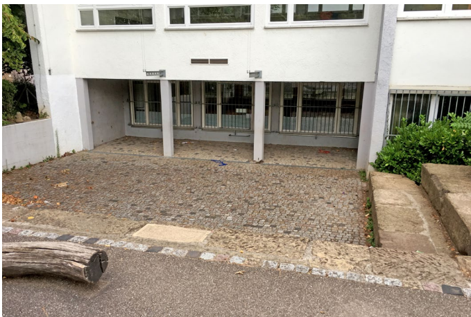
Tiefhof vor Umbau
