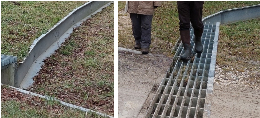
Abb. 8 Dauerhafte, gut instand zu haltende Absperreinrichtungen vom südwestlichen Gebietsrand nach außen gerichtet stellen eine wesentliche Schutzmaßnahme zur Vermeidung anlage- und betriebsbedingt erhöhter Tötungsrisiken für ansonsten laufend einwandernde Wechselkröten in das neue, im B-Plangebiet zu entwickelnde Siedlungsgebiet dar. Sie sind allerdings (vgl. Text) nach Aussagen des Grünflächenamtes nur für einen geringen Teil des Gebietsrandes umsetzbar. Zuführende Wege im Kontext der angrenzenden Schwerpunktorkommen sind wo möglich mit Fangrinnen und beidseitig anschließenden Ausgängen im Anschluss an die Absperreinrichtungen zu versehen (Beispiel im rechten Bild). Die Aufnahmen stammen aus einem anderen Gebiet (Fotos: J. Trautner).
