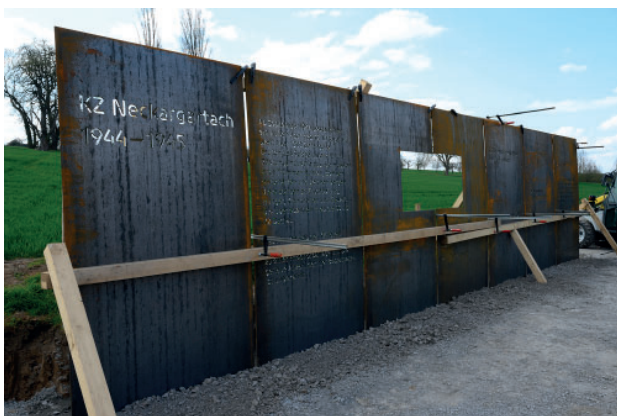
Baustelle des neuen KZ-Gedenkorts in Neckargartach
