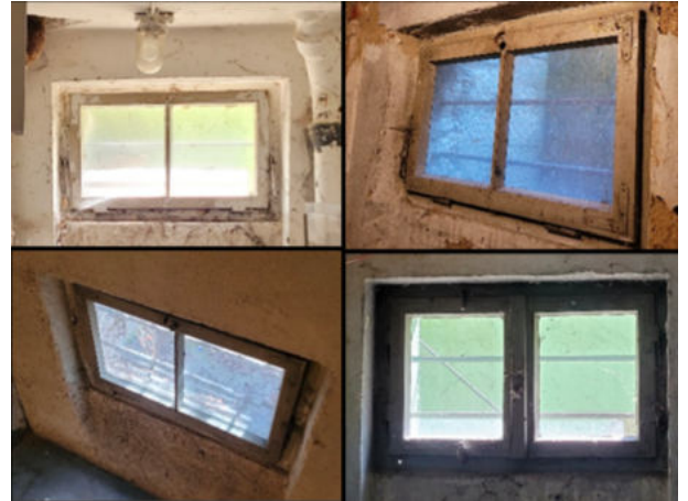
Abb. 10: Diverse dauerhaft und permanent verschlossene Kellerfenster von Gebäude A.
