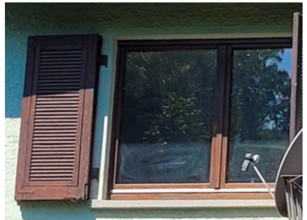
Abb. 6: Unbenutzte Fensterläden stellen potentielle Fledermausquartiere dar.
