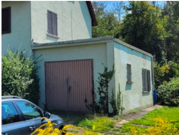
Abb. 11: An Gebäude A angebaute Garage (Gebäude Nr. B nach Abb. 2).
