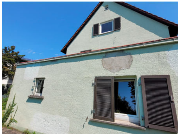
Abb. 13: Fensterläden als potentielle Fledermausquartiers an der westlichen Garagenwand.
