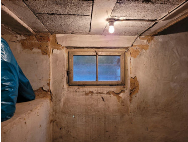
Abb. 9: Unzugänglicher Kellerraum von Gebäude A ohne jegliche Spuren tierischer Nutzung.
