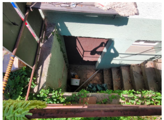
Abb. 8: Äußerer Kellerzugang von Gebäudes A mit verschlossenem Fenster.
