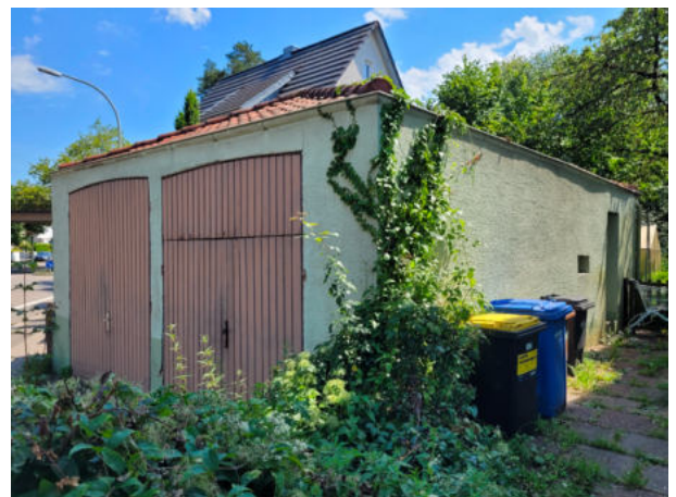
Abb. 18: Blick auf Gebäude C aus Nordwesten ohne Hinweise auf eine tierische Nutzung.
