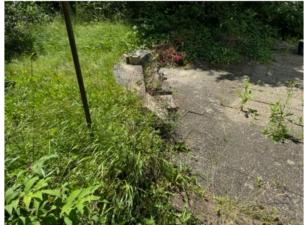
Abb. 9: Südseite des Wohngebäudes mit vorgelagerter Betonplattenfläche.
