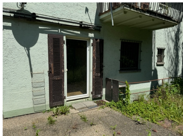
Abb. 7: Südseite des Wohngebäudes mit vorgelagerter Betonplattenfläche.
