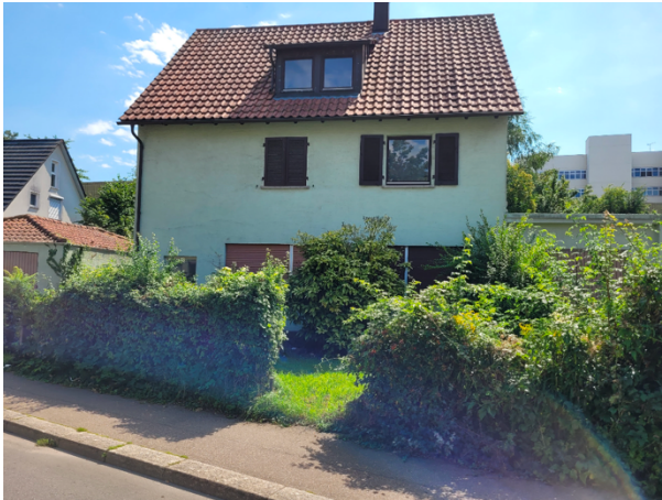
Abb. 2: Nordseite des Wohngebäudes dominiert von Waldrebe und Sukzession (altes Bild: 2023).
