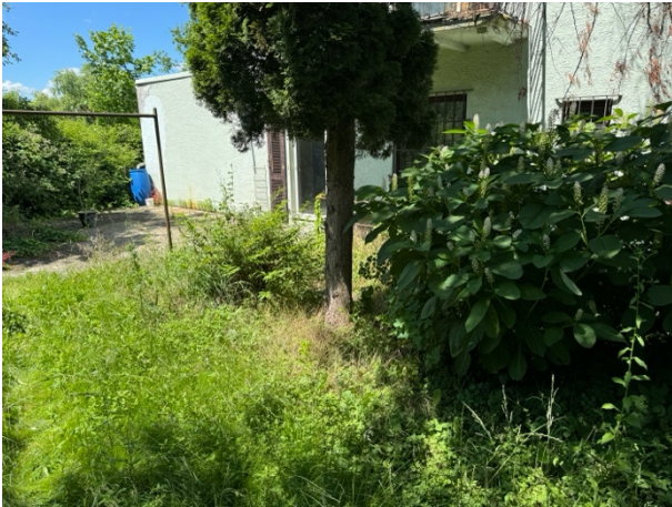
Abb. 8: Südseite des Wohngebäudes mit vorgelagerter Betonplattenfläche.
