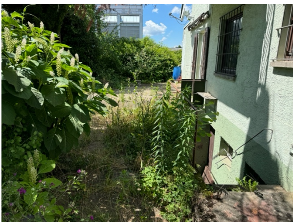
Abb. 6: Südseite des Wohngebäudes mit vorgelagerter Betonplattenweg.
