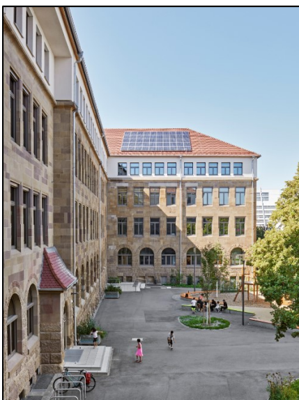
Abbildung 58: Äußeres Erscheinungsbild der Schulen nach Abschluss der Sanierungsarbeiten
