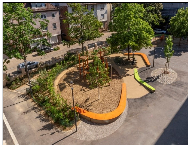
Abbildung 59: Schulhof nach der Sanierung
