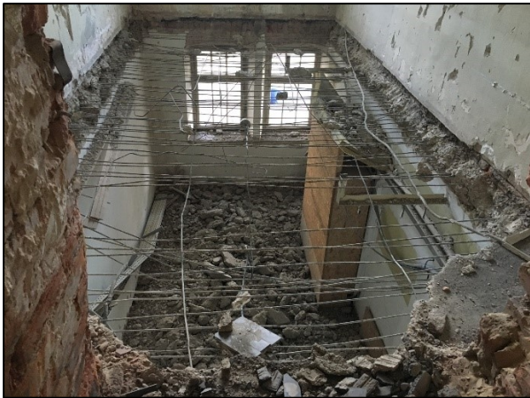
Abbildung 60: Deckensanierung
