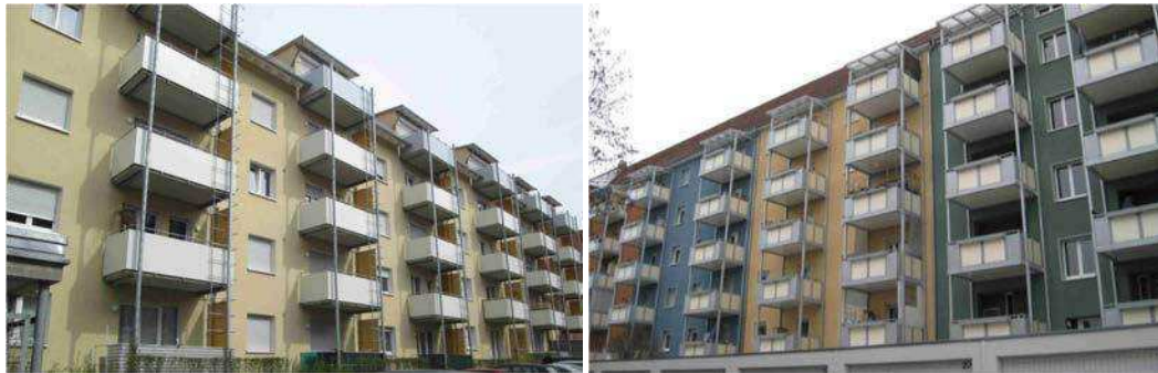
Foto 24 & 25: Beispiel - Balkonlandschaften mit angebrachten Balkonen (links) und wärmebrückenfrei vorgestellten Balkonen rechts. Quelle: ebök
