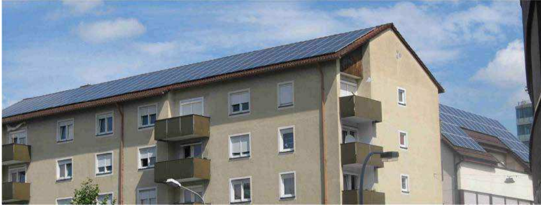
Foto 21: PV Anlagen in der Turmstraße. Quelle ebök.
