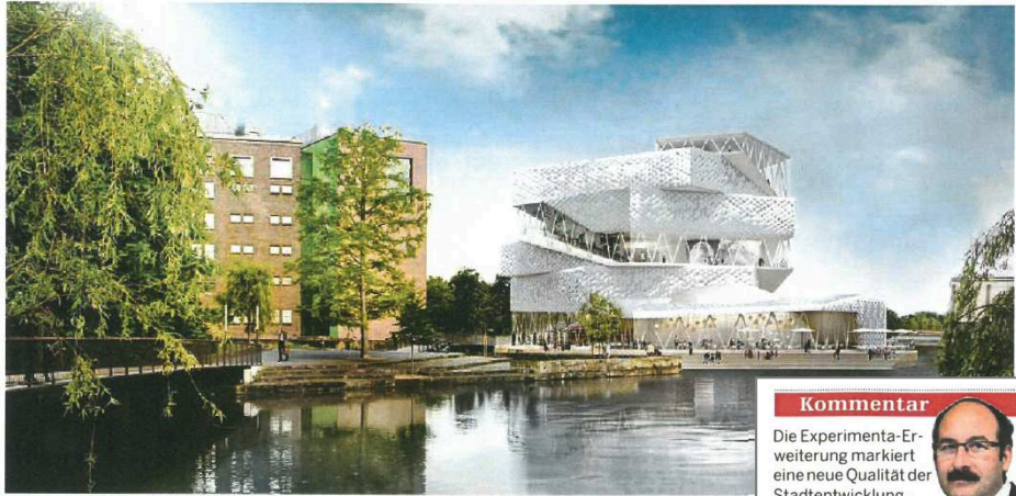
Der Neubau entsteht ab Frühjahr 2015 in direkter Nachbarschaft zur bestehenden Experimenta. Ende 2017 soll alles fertig sein.
