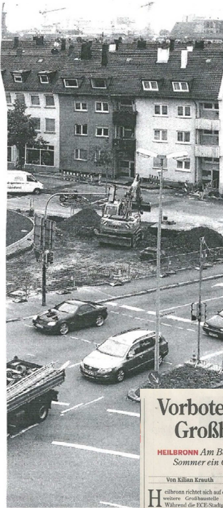
Seit Februar wurde an der Unteren Neckarstraße die Gerberstraße verlängert.
