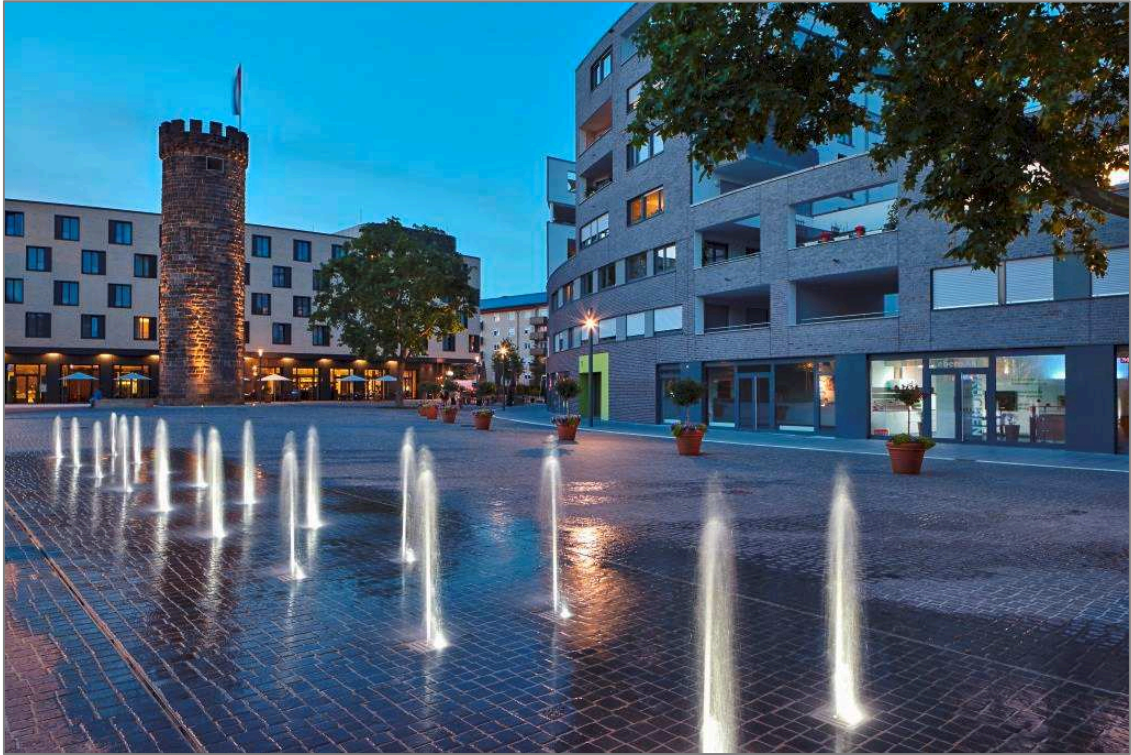
Abbildung 69: Der Platz am Bollwerksturm mit den beiden Neubauten Hotel Mercure (nördlich hinter dem Bollwerksturm) und dem Domizil Riverside (rechts im Bild). © Christina Kratzenberg | Biegert Landschaftsarchitektur
