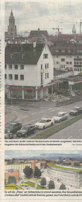
Der Ausbau in der Unteren Neckarstraße ist bereits ausgebaut. Rechts: Wochenplan der Abbrucharbeiten auch den Straßenverkehrsamt.
