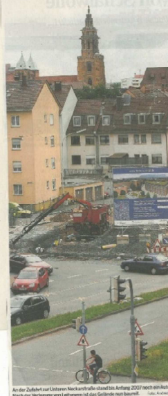
An der Zufahrt zur Unteren Neckarstraße stand bis Anfang 2007 noch ein Autohaus. Nach der Verlegung von Leitungen ist das Gelände noch baufrei.
