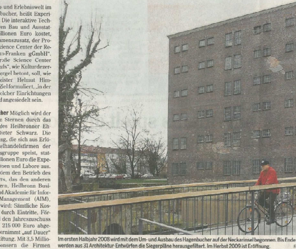
Im ersten Halbjahr 2008 wird mit dem Um- und Ausbau des Hagenbucher auf der Neckarinsel begonnen. Bis Ende dieses Monats werden aus 31 Architektur-Entwürfen die Siegelpläne herausgefeilt. Im Herbst 2009 ist Eröffnung. Foto: Dittmar Deiks
