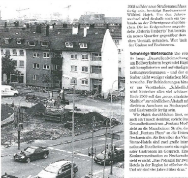
2008 soll der neue Straßenausbau fertig sein, benötigt Baubereitungen Wilfried Hajek. Um das Jahresende wird die Baugrube nach ein Gelände an der Zehnhäusergasse abgebrochen. Die im ECE-Deutscherhof steht ein neues Quartier gegenüber dem alten Deutscherhof. Hier hat der Neubau ein Hochhaus.
