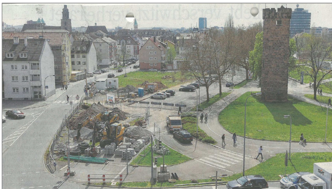
Abbildung 45: Bildauszug aus dem Presseartikel der Heilbronner Stimme „Aus für Gesundheitszentrum“ vom 06.04.2011. Die Abbildung zeigt das frühere Areal am Bollwerksturm von der „Mannheimer Straße“ in Blickrichtung Süden. Es werden bereits Abbruch- und Leitungsverlegungsarbeiten durchgeführt. Die Untere Neckarstraße ist gesperrt und deren Rückbau vorbereitet. Links im Bild verläuft die Gerberstraße.
