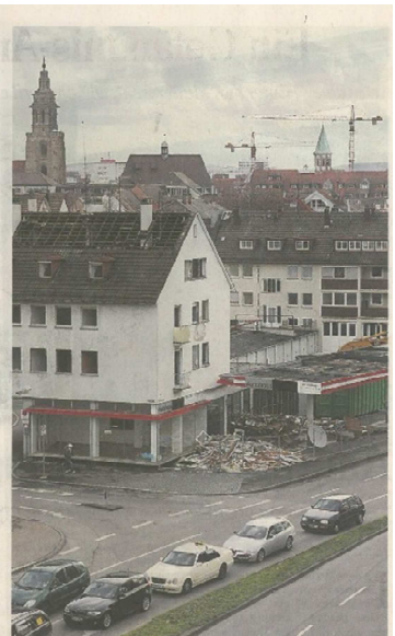
Das Autohaus an der Unteren Neckarstraße ist bereits ausgebeutet. Nächste Woche tangieren die Abbrucharbeiten auch den Straßenverkehr. Foto: Andreas Weigel
