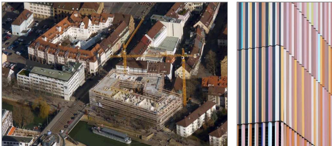
Abbildungen 26 und 27: In den Jahren 2014 bis 2016 wurde das neue Marrahaus errichtet.
