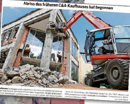
Abriß des früheren C&A-Kaufhauses hat begonnen Heilbronn Das Magier sind aufgeben, die Abrißarbeiten sind im Fortschritt. Die Baugrubensicherung ist im Gange. Die Baugrubensicherung ist im Gange.
