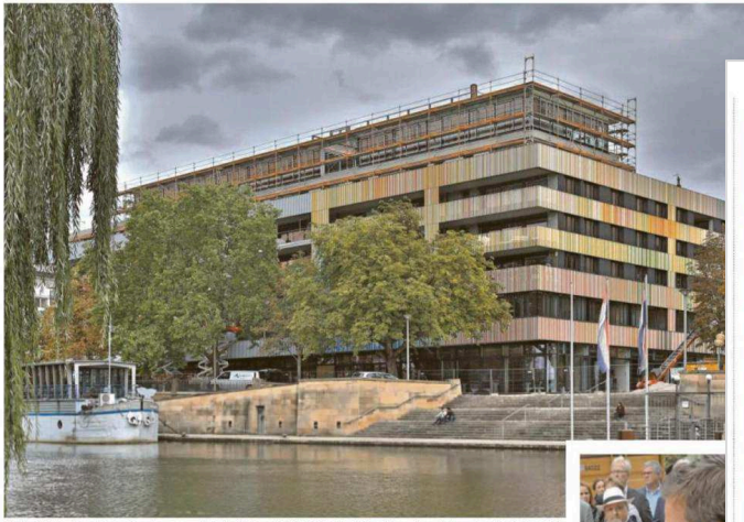
Die Ansicht der Fassade des Marrahauses verändert sich je nach Blickwinkel des Betrachters, denn die Lamellen-Dreiecke sind in 47 Farben unterschiedlicher Stärken ausgebildet – es gibt kräftige und zurückhaltende Kombinationen. Foto: Kruck+Partner
