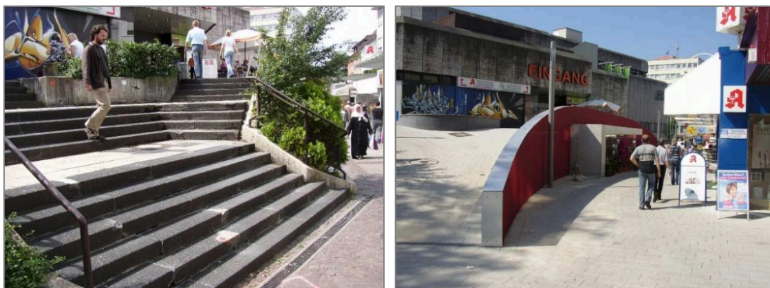
Abbildungen 35 und 36: Die alte Treppenanlage im Vergleich zur neuen Treppenanlage
