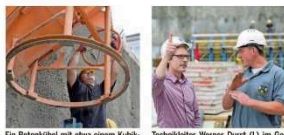
Ein Betonkübel mit etwa einem Kubikmeter Inhalt wird gerade geöffnet. Techniker Werner Durst (l.) im Gespräch mit Peter Steffen Groß.
