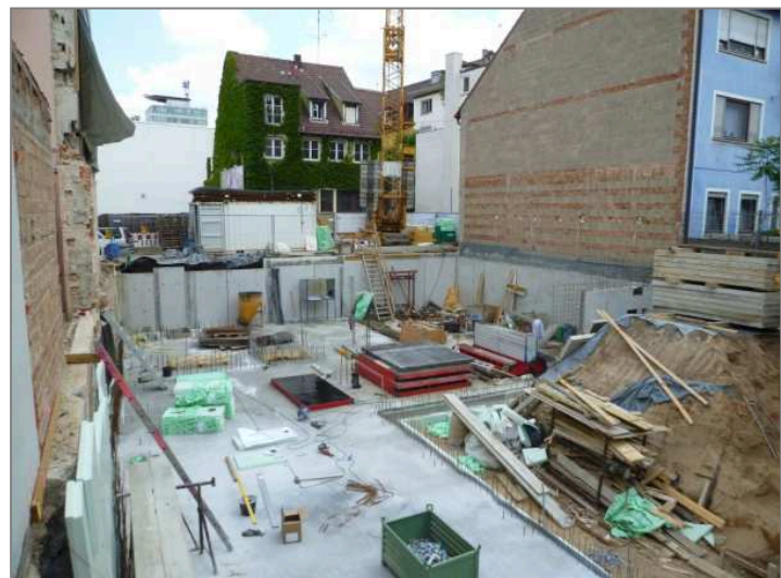
Realisierung der Neubaumaßnahme
