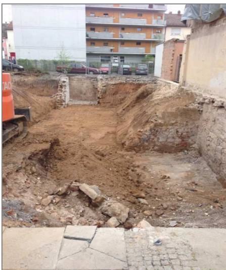
Abbruch der alten Bausubstanz
