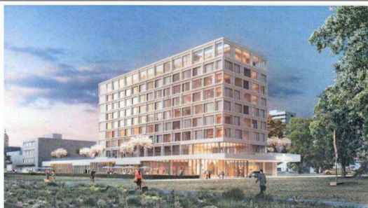
Der erste Preis. Unten eingeschossig das Restaurant, auf ihm ruht alleits zurückgesetzt der achtstöckige Hotelbau. Im ersten Stock die Tagungsräume mit umlaufender Terrasse. An der Stirnseite des Gebäudes der Haupteingang. Fotos: Dennis Magler
