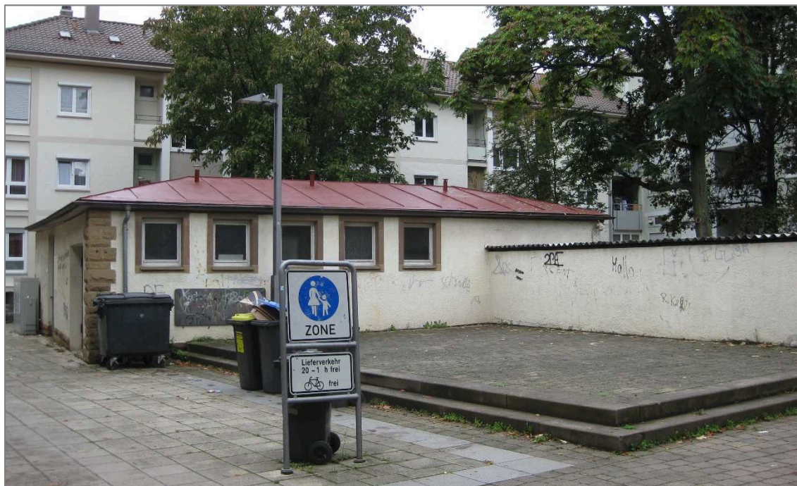
Abbildung 47: Ausgangslage vor Baubeginn, im Winter 2014.
