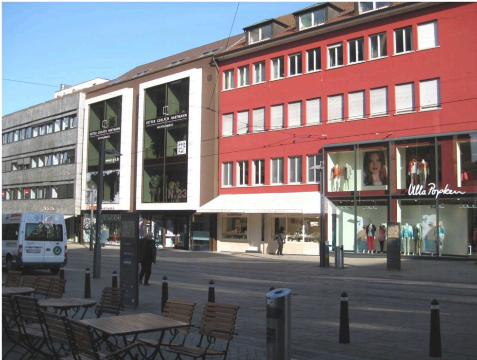
Umfeld Klosterhof - nördliche Seite Kaiserstraße, Gebäude 21 - 23/1
