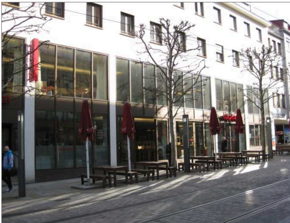
Umfeld Klosterhof - nördliche Seite Kaiserstraße, Gebäude 27
