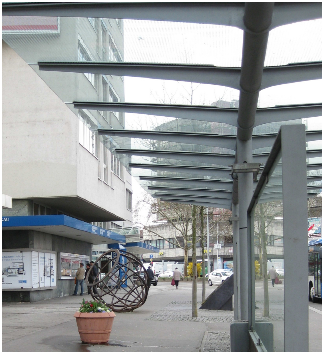
Ansicht östliche Allee nach Rückbau Unterführung; neue Raumsituation im Bereich der ehem. Synagoge
