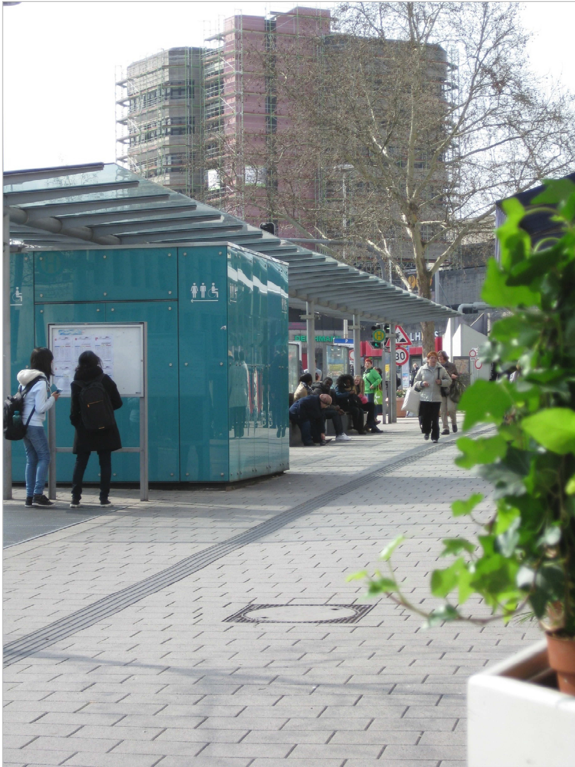
Ansicht westliche Allee nach Rückbau der Unterführung/ Neubau öffentliche Toilettenanlage
