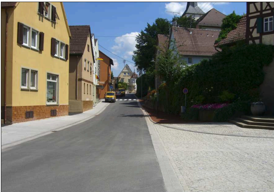
Bild: Unterlandstraße - Straßenraum nach der Umgestaltung Standort Einmündung Ziegeleistraße, Blickrichtung Unterlandstraße 17
