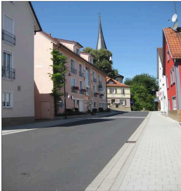
Bild: Unterlandstraße nach der Umgestaltung Standort Unterlandstraße 21, Blickrichtung Unterlandstraße 14
