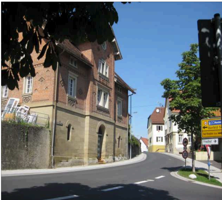
Bild: Unterlandstraße nach der Umgestaltung, Standort Kurvenbereich/ Einmündung Rappengasse, Blickrichtung Bonfelder Straße 7
