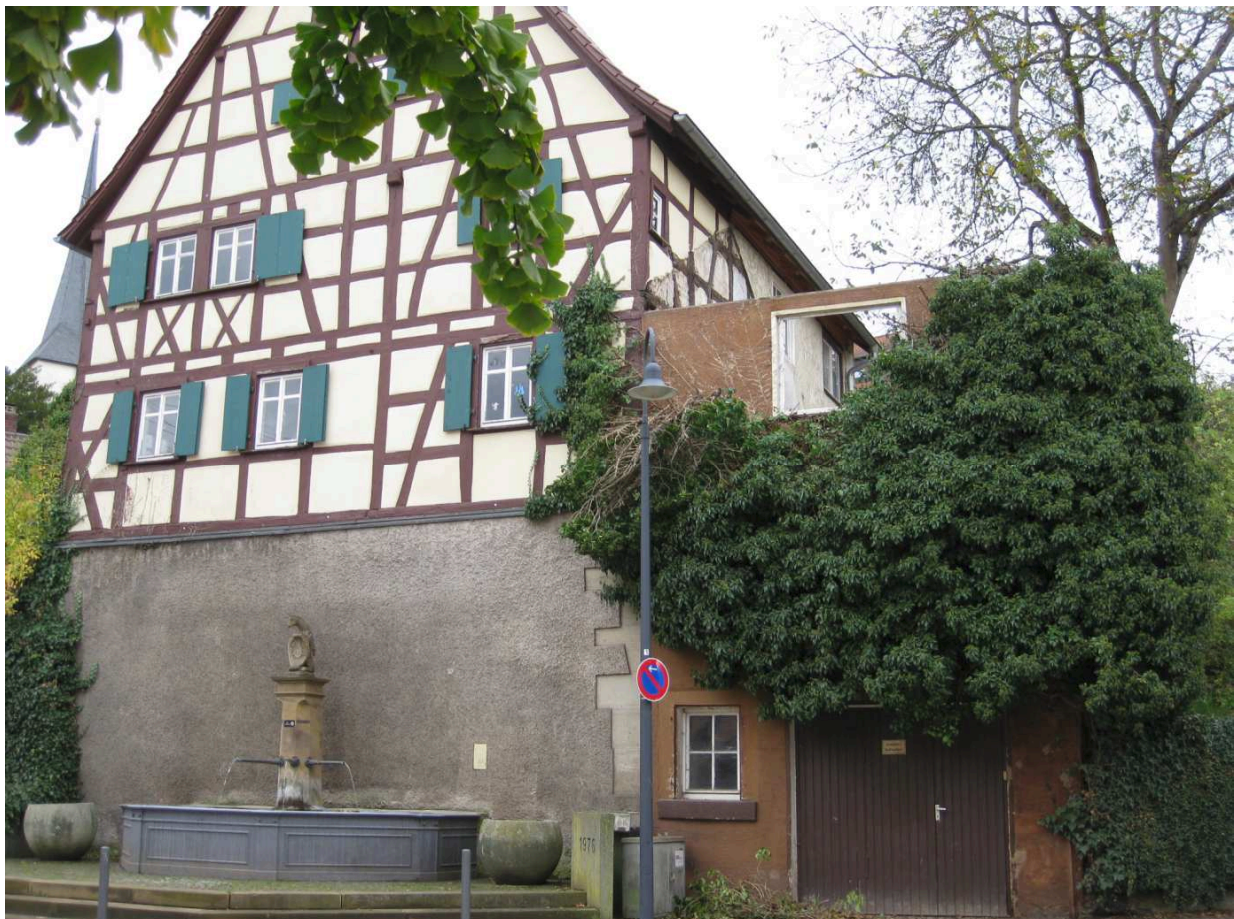
Bild: Gebäude Unterlandstraße 2 vor der Modernisierung mit unvollendetem, abbruchreifem Anbau
