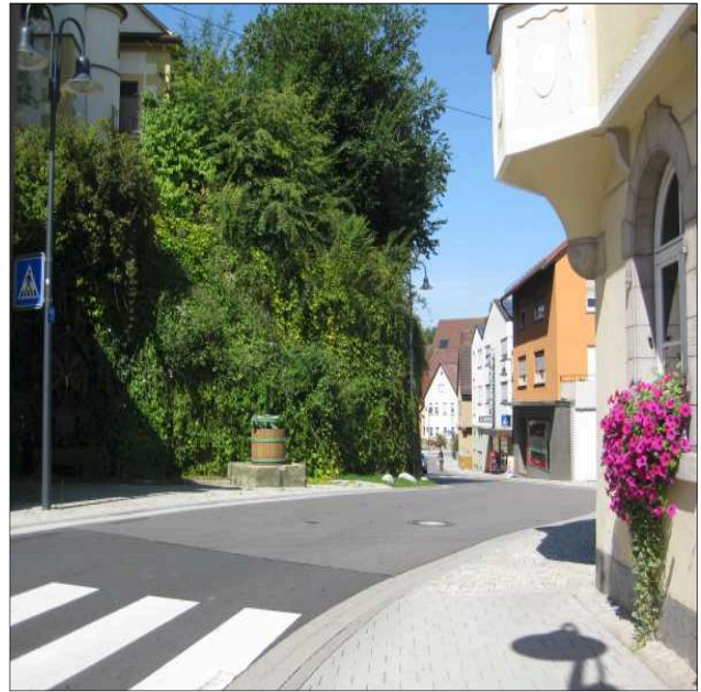
Bild: Unterlandstraße nach der Umgestaltung Standort Unterlandstraße 17, Blickrichtung Unterlandstraße 13
