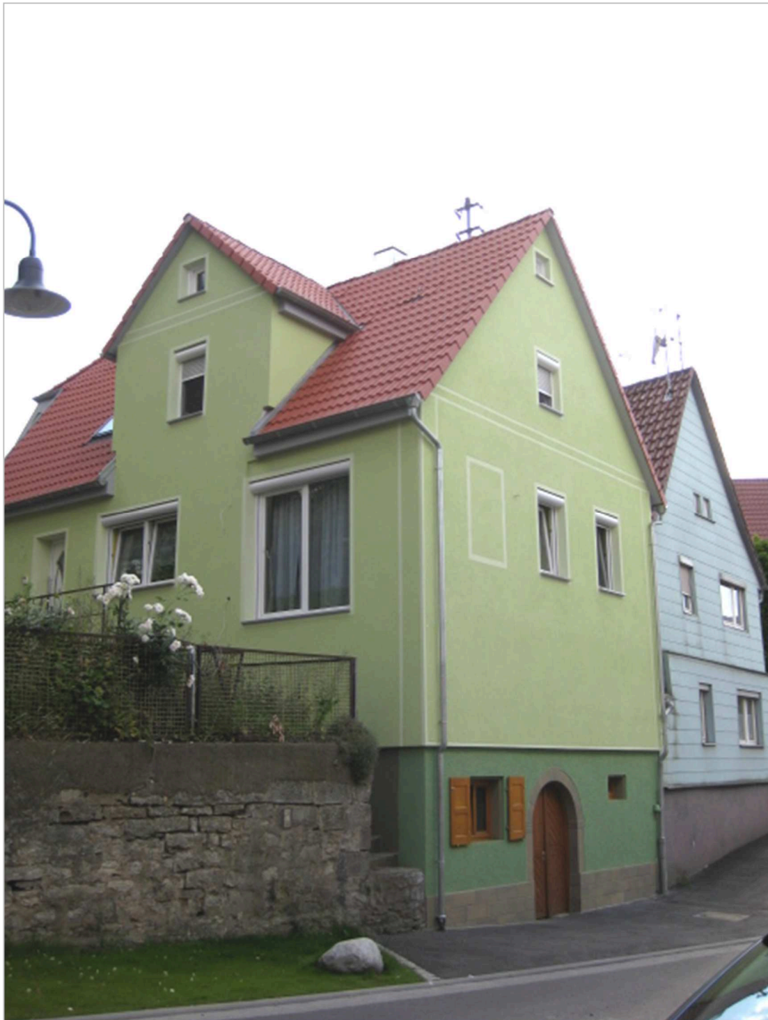
Bild: Gebäude Unterlandstraße 6 nach Abschluss der Baumaßnahmen
