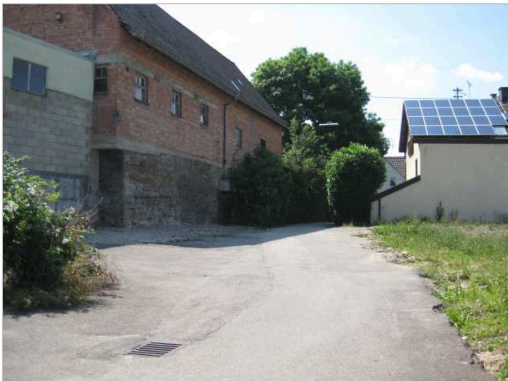
Bild: Rappengasse - nach Abbruch der Nebengebäude auf dem Anwesen Rappengasse 6
