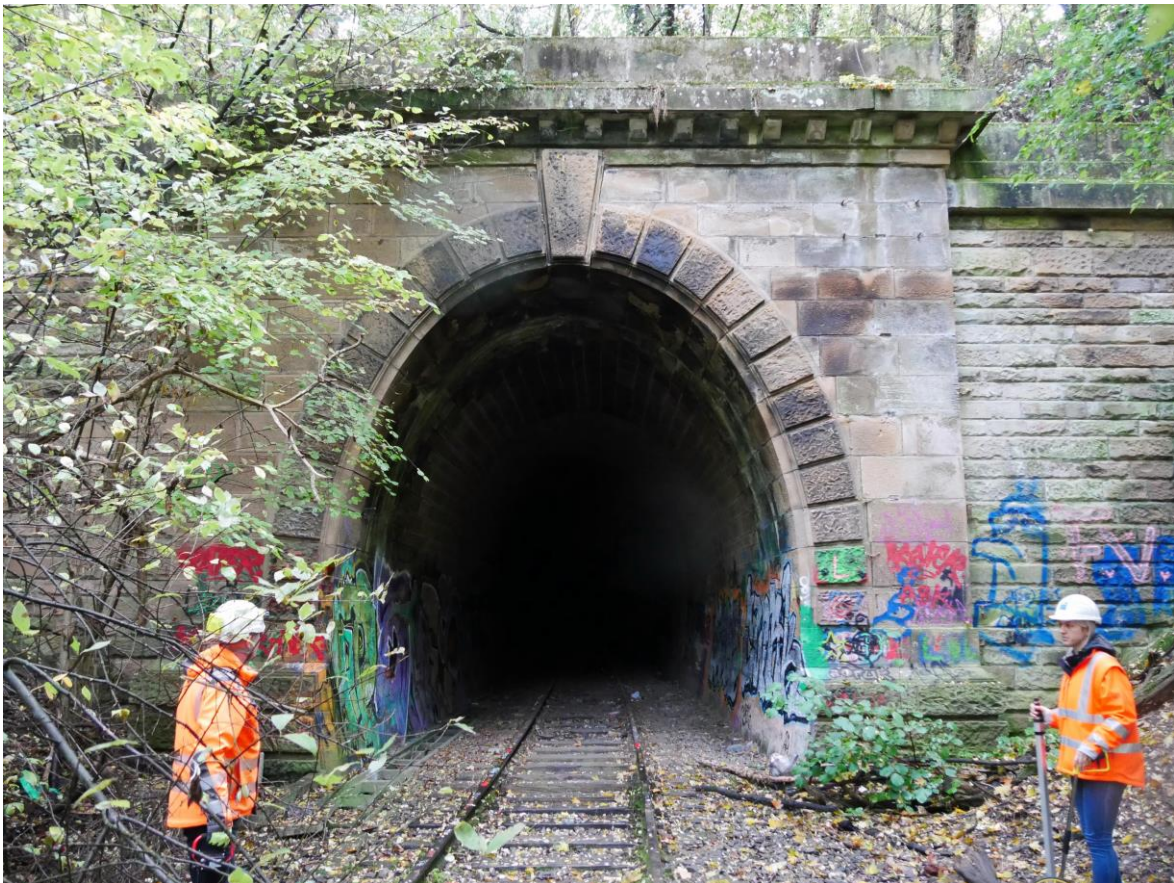
Bild 1: Situation am Südportal des Lerchenbergtunnels.
