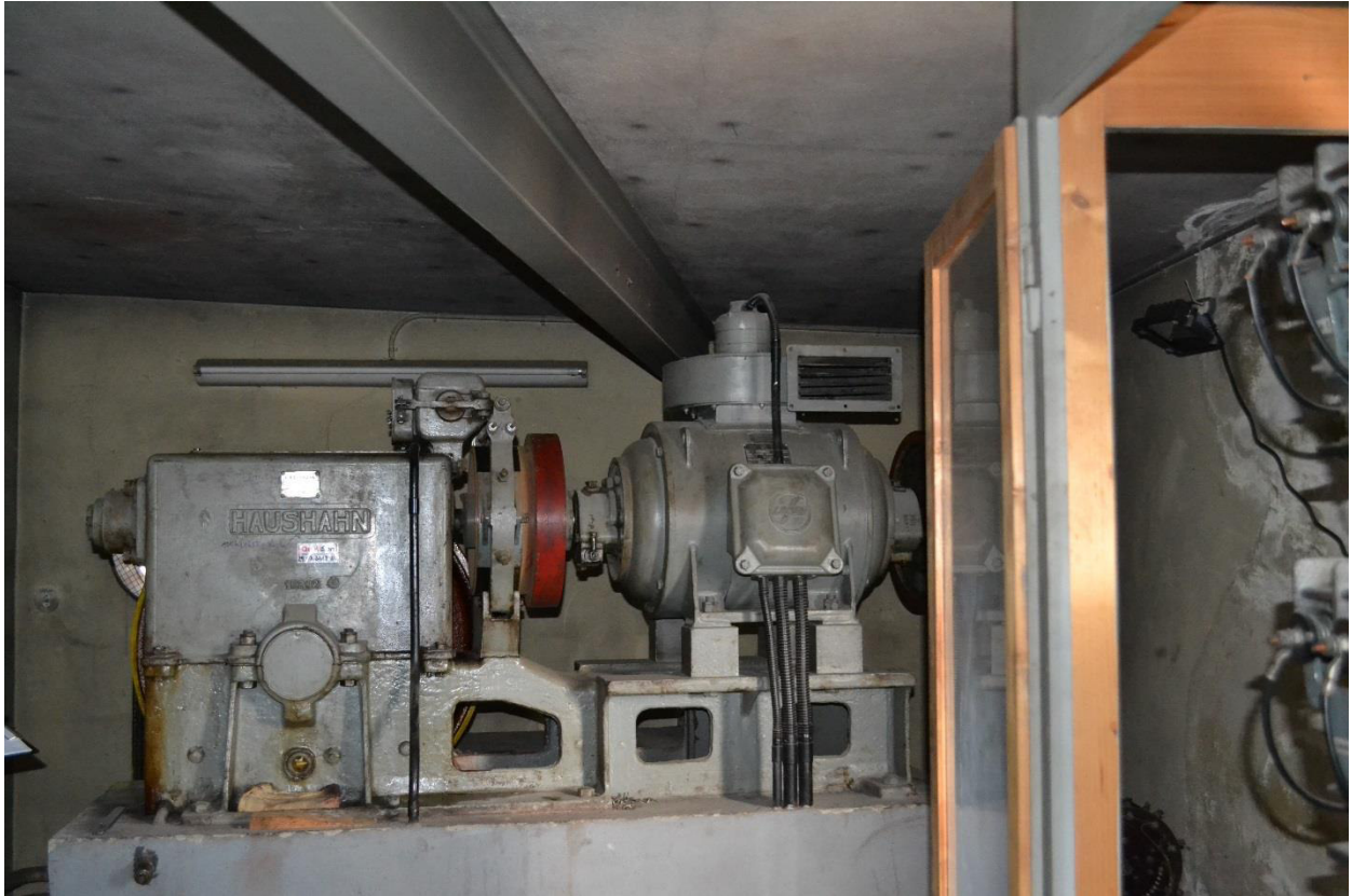
Abb. 7: Dachbereich des Gebäudes mit Aufzugstechnik (Foto: B. Beier).
