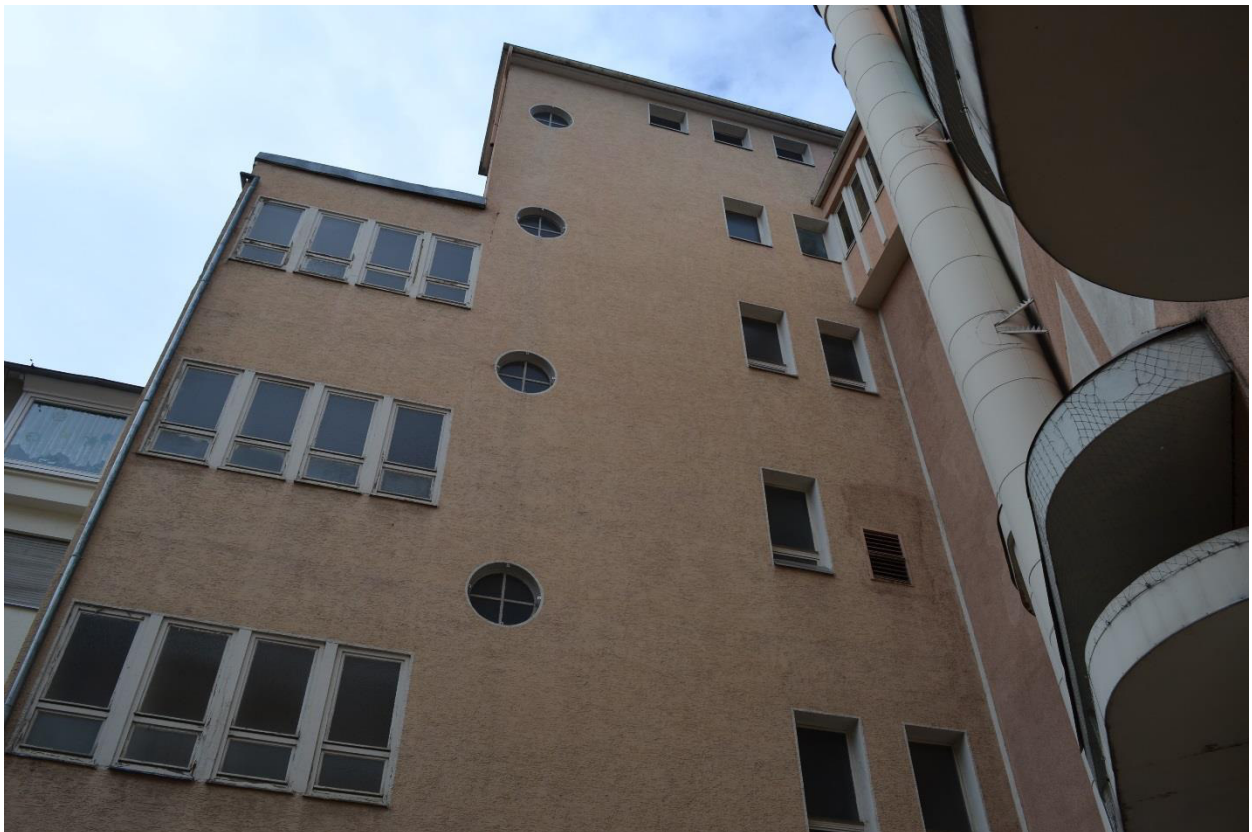
Abb. 6: Fassade und Dachbereiche des Gebäudes vom Innenhof des Flurstücks 48/5 aus (Foto: B. Beier).
