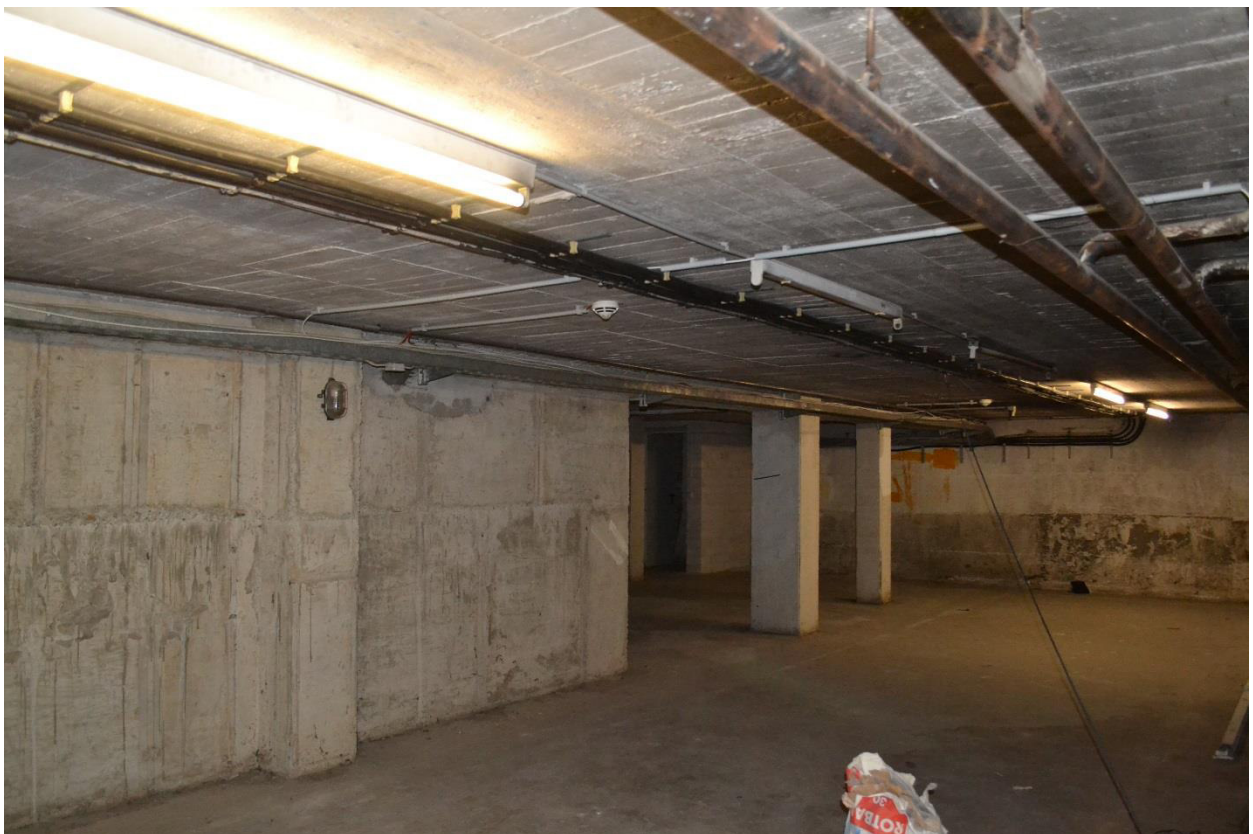
Abb. 10: Kellerbereich des Gebäudes (Foto: B. Beier).
