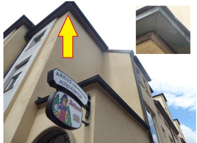
Abb. 10: Gebäudeteil 5 ohne potentielles Spaltenquartier am Dachüberstand.
