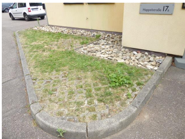
Abb. 15: Rasengitterpflaster mit Schotterstreifen vor Gebäude Happelstraße 17a.
