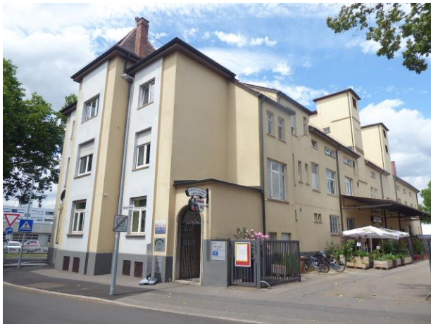
Abb. 9: Blick auf das Gebäude Happelstraße Nr. 17 (Gebäudeteil 5) aus südöstlicher Richtung.
