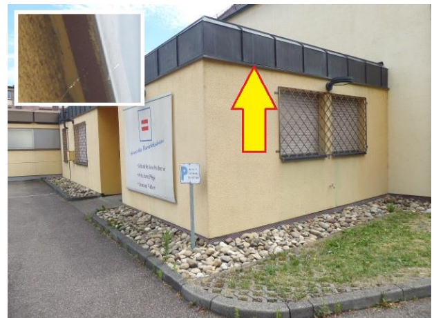
Abb. 6: Gebäudeteil 3 mit Querprofil unter Flachdach ohne Quartiereignung.
