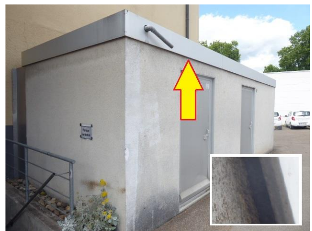
Abb. 8: Gebäudeteil 4 ohne potentielles Spaltenquartier unter dem Querprofil.
