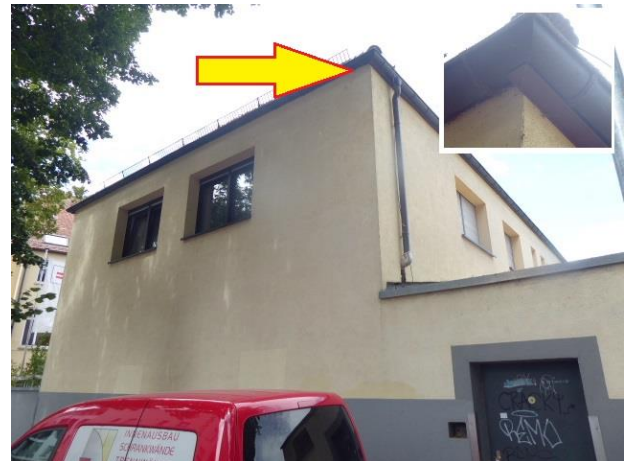
Abb. 4: Gebäudeteil 2 ohne potentielles Spaltenquartier am Dachüberstand.
