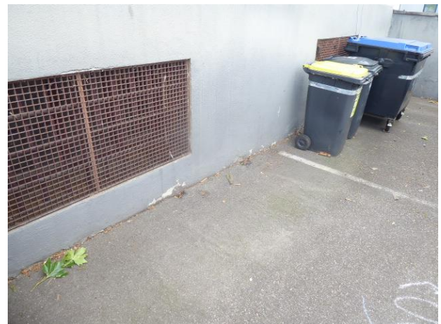
Abb. 14: Mit Gitter verschlossenes Kellerfenster von Gebäudeteil 5.
